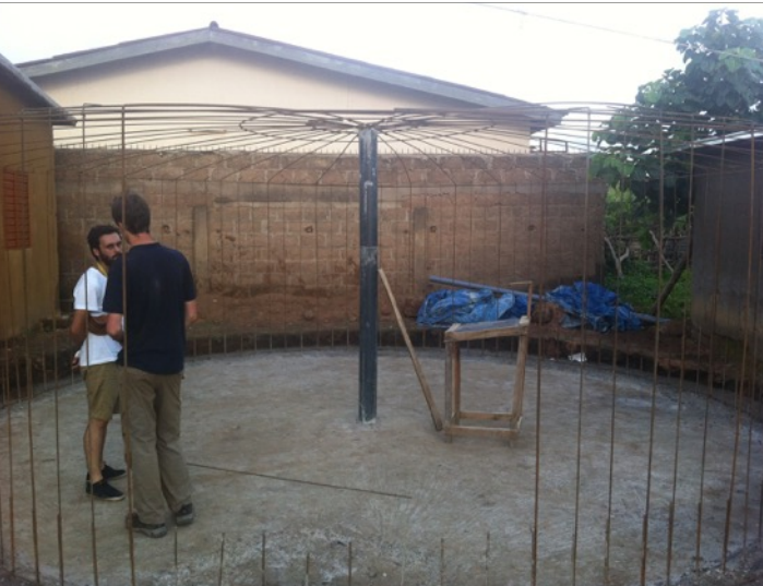
IMAGEN: Tanque en construcción
