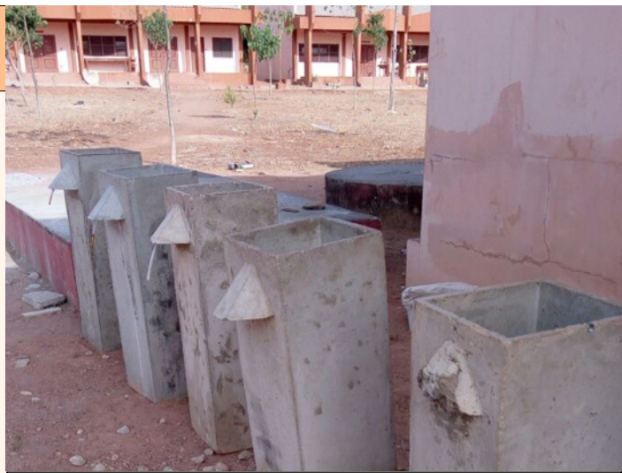
IMAGEN: filtros construidos por los albañiles
