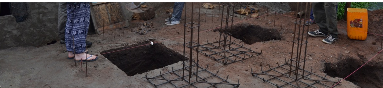
IMAGEN: Construcción de la torre de agua
